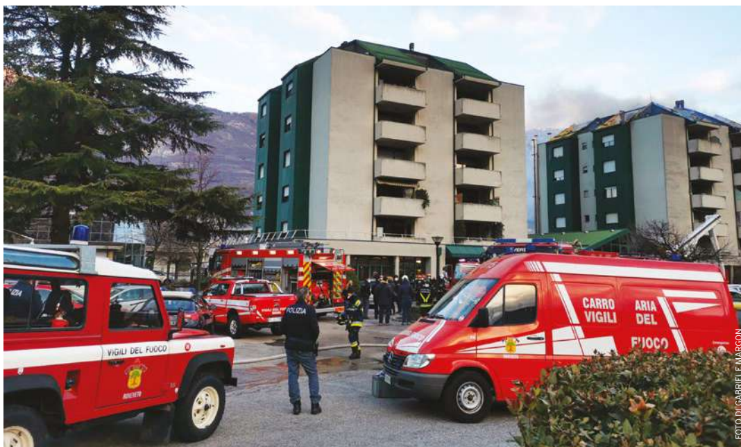
Distrutti tetto e soffitte, salvi gli appartamenti
