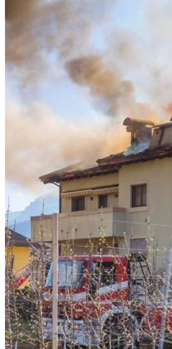
Il tetto e la mansarda divorati dal fuoco
