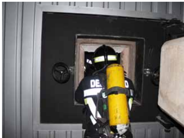
I vigili del fuoco entrano con le procedure codificate (con bastino e bombola svestito) attraverso l'oblò (cm. 40 x 40) nella caldaia a cippato spenta e in manutenzione per soccorrere un operaio
