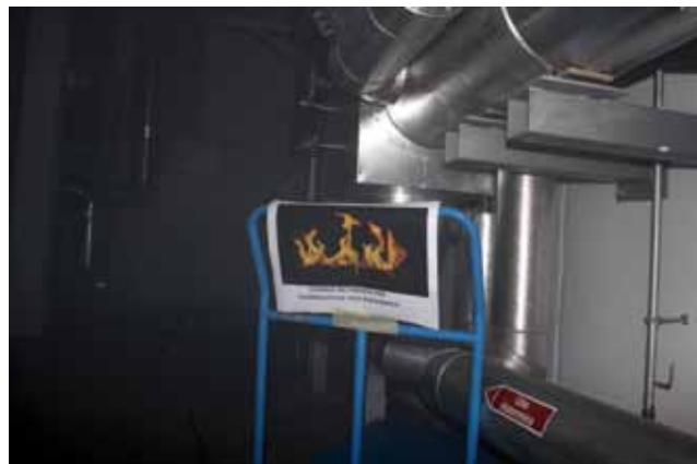
La flangia dove è simulata la perdita di olio diatermico con sviluppo di incendio
