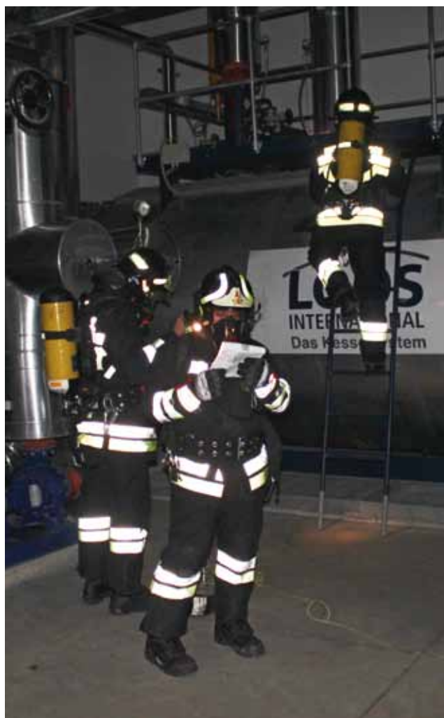
Si verifica il deposito olio diatermico a 315 gradi centigradi
