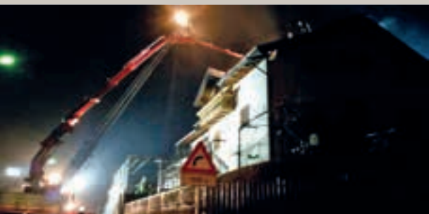
L'INTERVENTO DEI VIGILI NELLA FRAZIONE DI TOMASELLI
