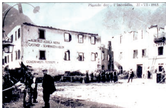
L'albergo Aquila Nera di Pinzolo distrutto dalle fiamme
