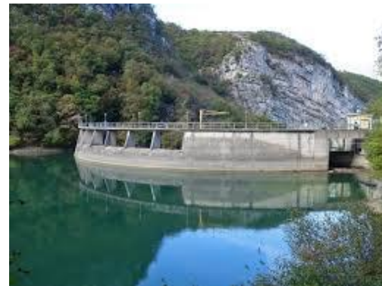
Diga e centrale di San Colombano
